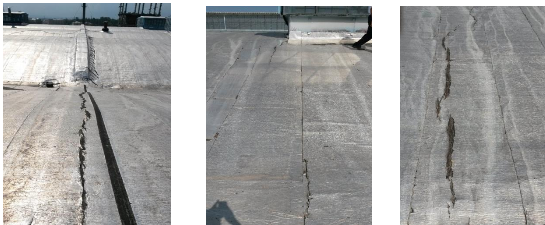
Рис.1. Фрагменты технически аварийного состояния ограждающего слоя кровли
