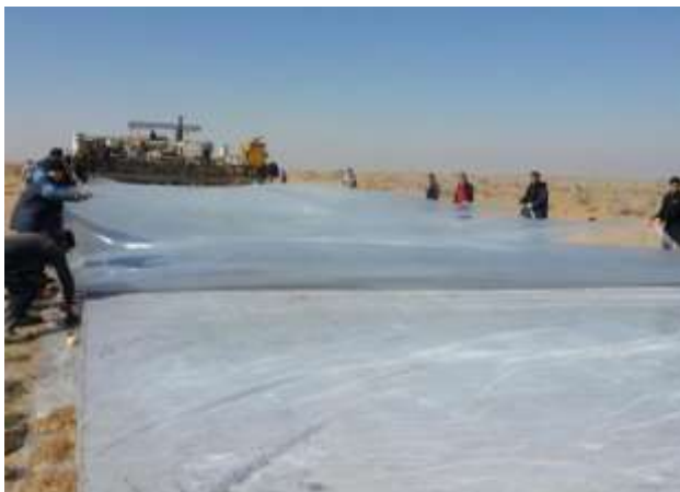
Рис. 1. Последовательность работ, выполняемых для поддержания укладываемого покрытия при высоких температурах
