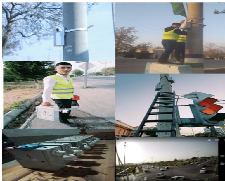
3-rasm Jizzax shahar markaziy chorraxalarida video kuzatuv kameralarini oʻrnatish jarayoni
